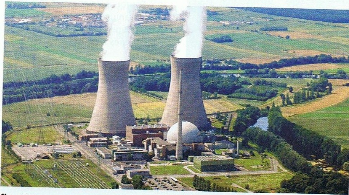
fig. 15 Cette centrale thermique évacue de l'énergie thermique sous forme de vapeur d'eau grâce à des tours de refroidissement.
