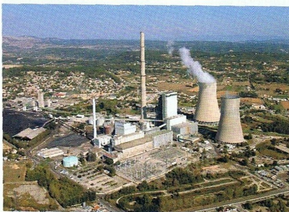
fig. 7 Centrale thermique de Gardanne. L'eau de refroidissement de la centrale est recyclée. Une partie de la vapeur s'échappe dans l'atmosphère au sommet des tours.
