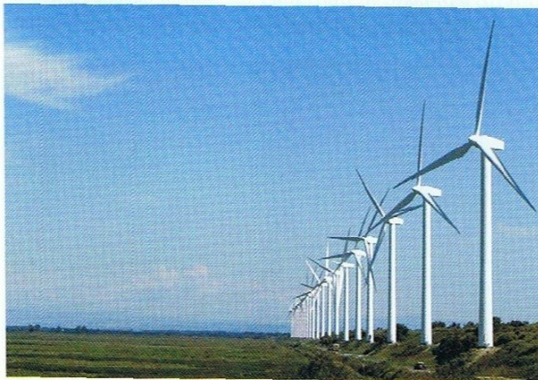
fig. 9 Champ d'éoliennes. Un mât de 2 à 3 mètres de diamètre, haut de 30 à 70 mètres, porte une hélice tripale à axe horizontal.
